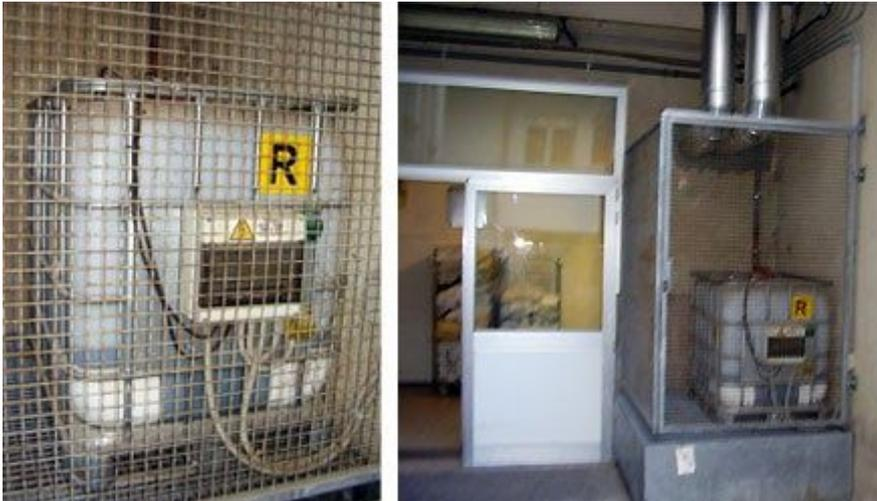
• Fotos N° 1 y N° 2 La cisterna recoge los líquidos del servicio de endoscopia digestiva; cuando se completan las 3/4 partes suena una alarma (tiene un periodo de 8-10 días para el recambio antes que se complete el 1/4 restante).
